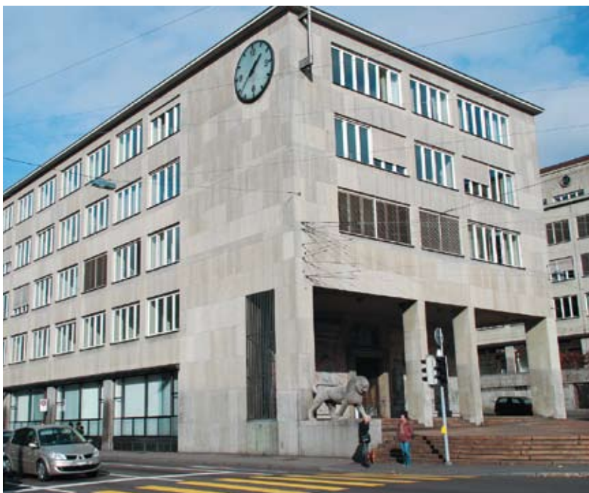
Gebäude der kantonalen Verwaltung Zürich, Quelle: Baudirektion Kanton Zürich
